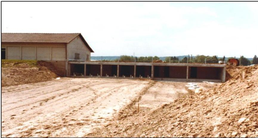
Der Rohbau der neuen Pistolenanlage ist dank durchdachter Planung schnell abgeschlossen. Die Bauschalung ist weg und die 25 und 50m Bahnen sind bereits grob nivelliert.
